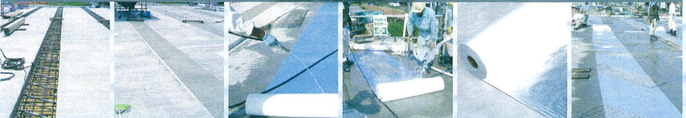
コンクリート打設前
