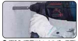
③ 打込み (専用マシンホルダー使用)
