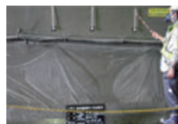
R側 塗布後
