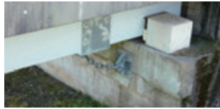
橋台の桁受け部
