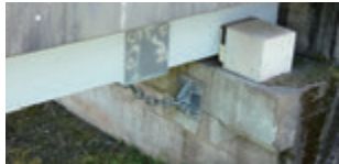
橋台の桁受け部
