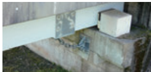
橋台の桁受け部
