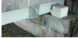
橋台の桁受け部
