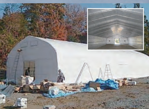
ビニールハウスの内側に施工
