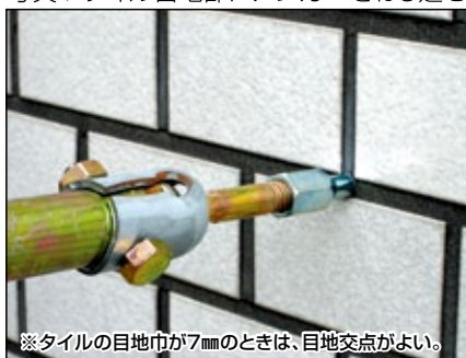
写真1 タイル目地部にアンカーをねじ込む
