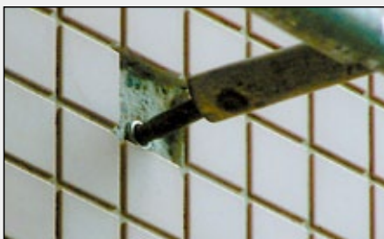
写真5 タイルの補修が必要
