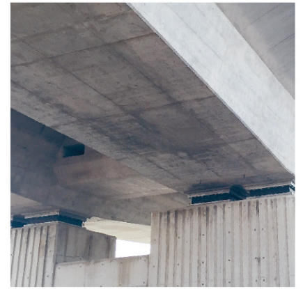
上部工仕上がり
