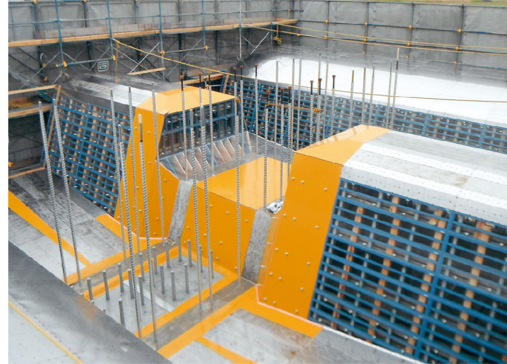
上部工全面施工
