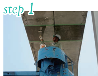
ワンガードクリアプライマー塗布
