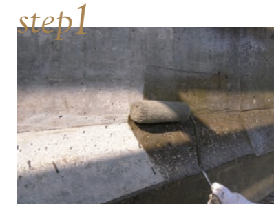
プライマー塗布
