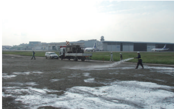
ハイドロシーダーによる施工状況
