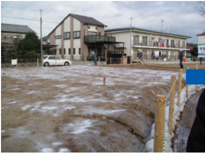
施工直後の状態
